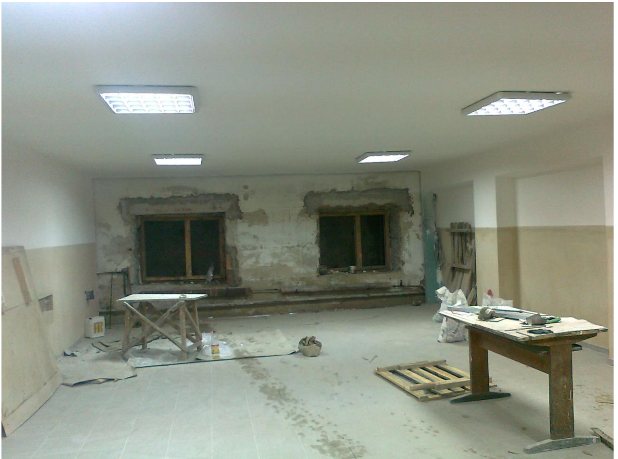
Під час ремонту приміщення для навчальної лабораторії «Механіка ґрунтів» (фото – серпень 2011 р.)
