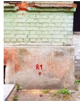
Рис. 9 – Влаштування стінових реперів
