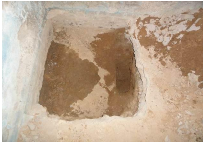
Рис. 7 – Виконання шурфів для досліджень основ та фундаментів
