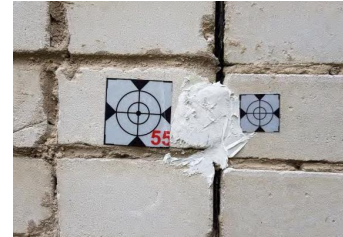
Рис. 8 – Влаштування плівкових відбивачів та гіпсових маяків
