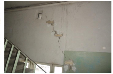
Рис. 8 – Влаштування плівкових відбивачів та гіпсових маяків
